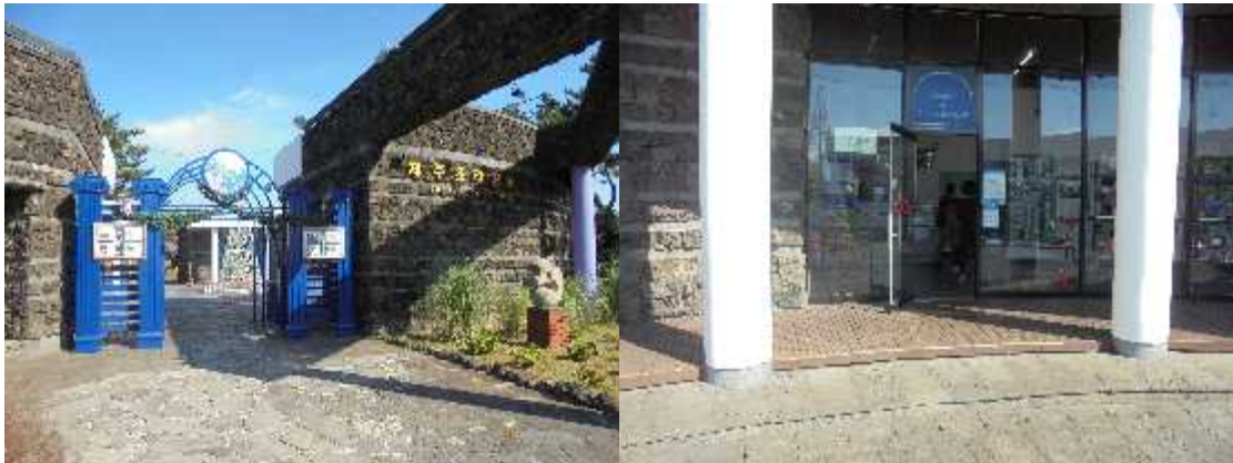
공원입구 / 매표소&화장실 건물 (단차 2개 / 10cn,12cm)
